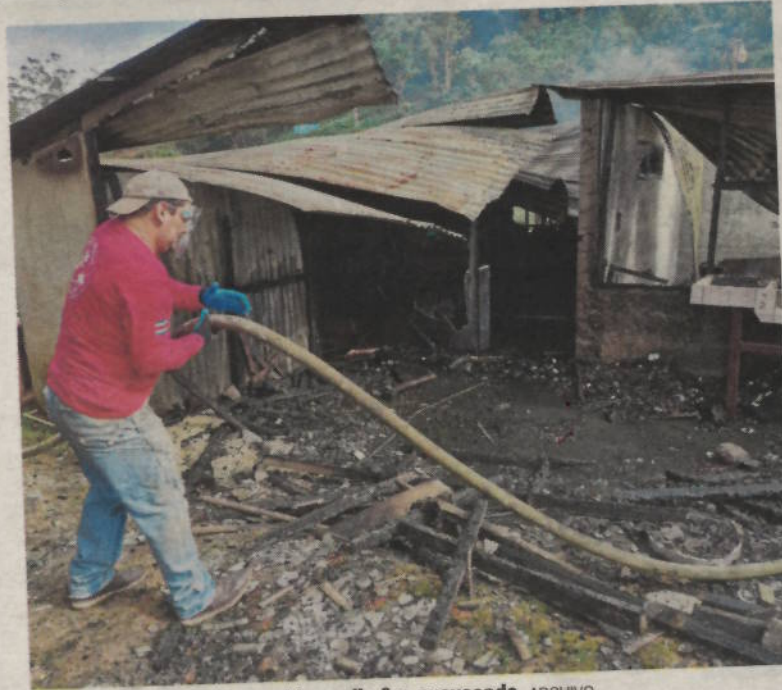
Bomberos descubrió que el incendio fue provocado. ARCHIVO
