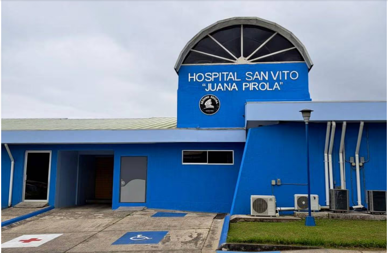
Así quedó la fachada del hospital. Foto CCSS
