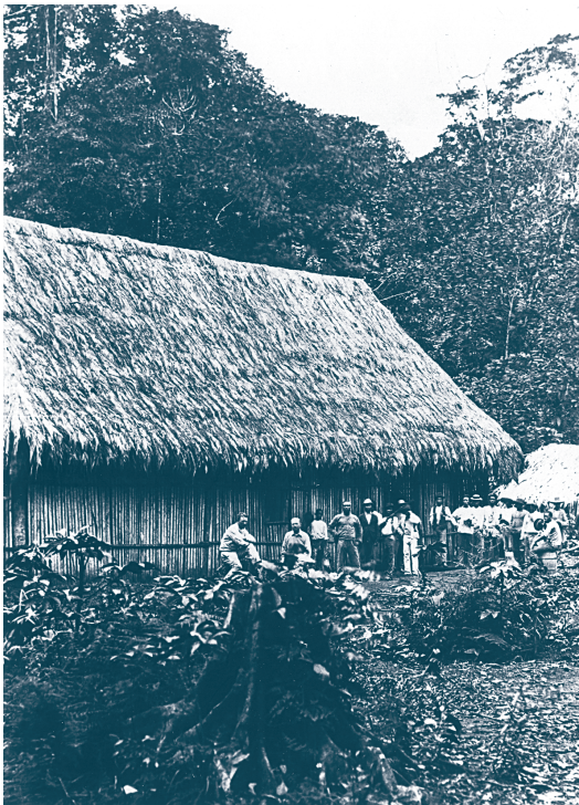
Campamento de trabajo del ferrocarril, Limón, ca. 1880 Fotografías 3449-1. Archivo Nacional de Costa Rica, San José, Costa Rica
