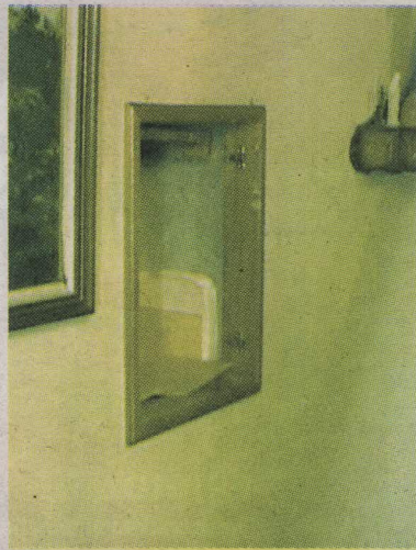
En esta pared estaba una de las cajas fuertes. WILBERTH HERNÁNDEZ GN.
