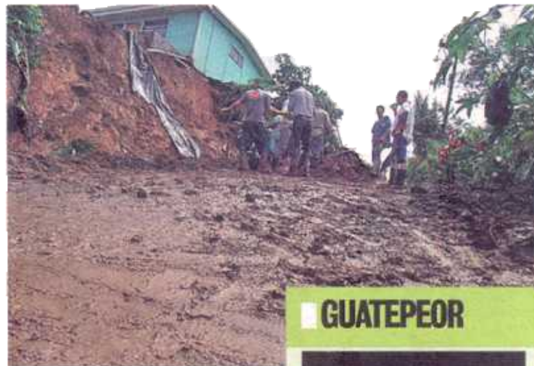
La casa de Saray ya no es habitable.
