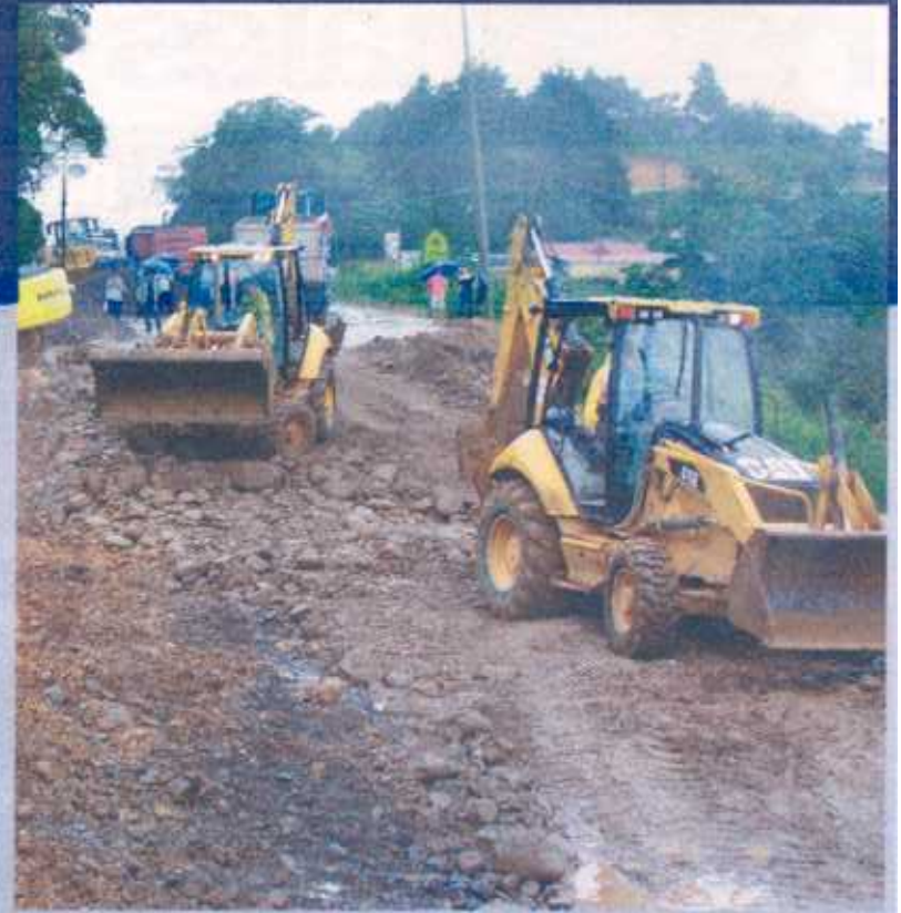
Las máquinas aún trabajan en el hundimiento en Cambronero. DIEGO CASTILLO/GN
