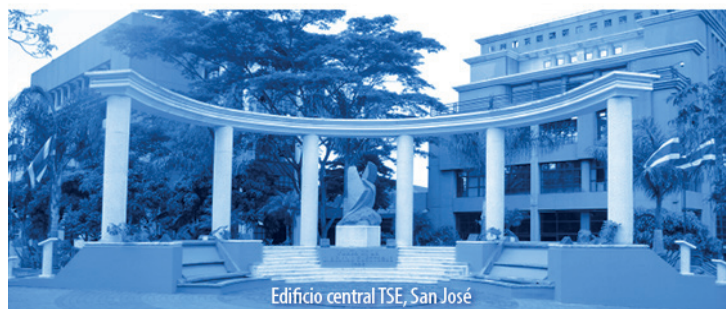
Edificio central TSE, San José
