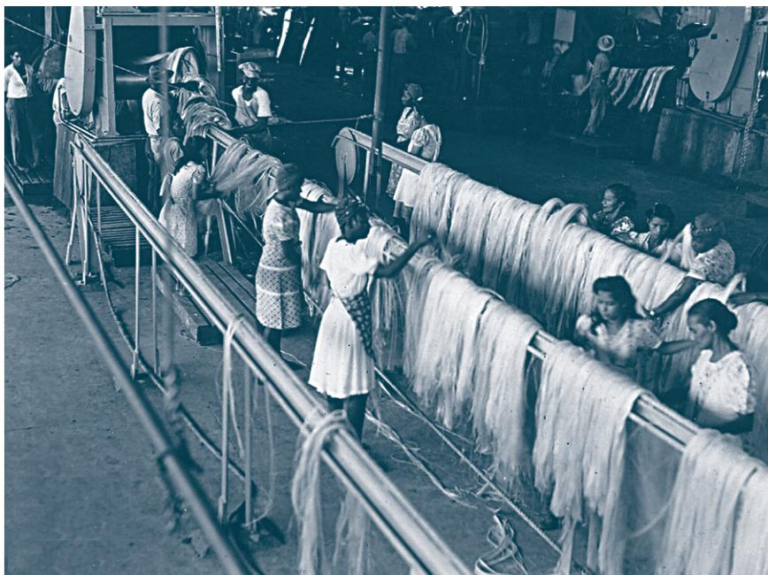
Mujeres haciendo madejas y calificando la fibra de abacá en la planta de la United Fruit Company en Monteverde, 1945. “Fibra en tiras llevadas del final de las máquinas descortezadoras a las cintas transportadoras para madejas y clasificación” Caja 61, Abaca Album 1.
